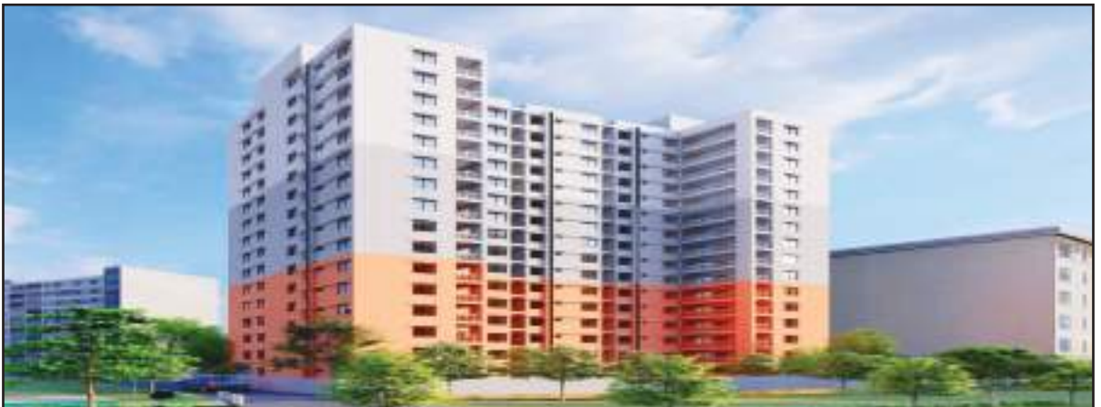
চট্টগ্রাম সিটি কর্পোরেশনের আওতাধীন পরিচ্ছন্নকর্মী নিবাস নির্মাণ
