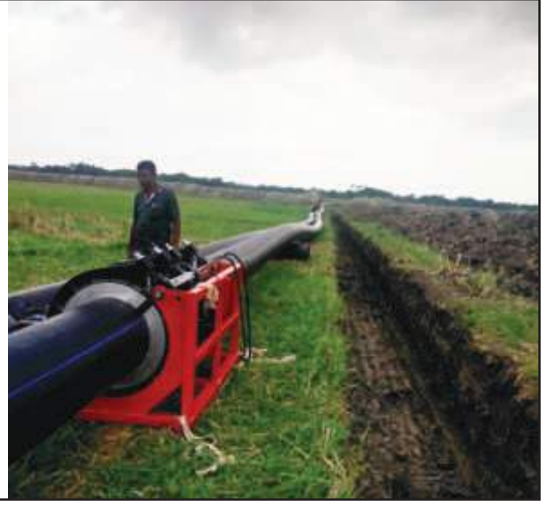
রাজশাহী জেলার বাগমারা উপজেলায় বারিড পাইপ স্থাপন কার্যক্রম
