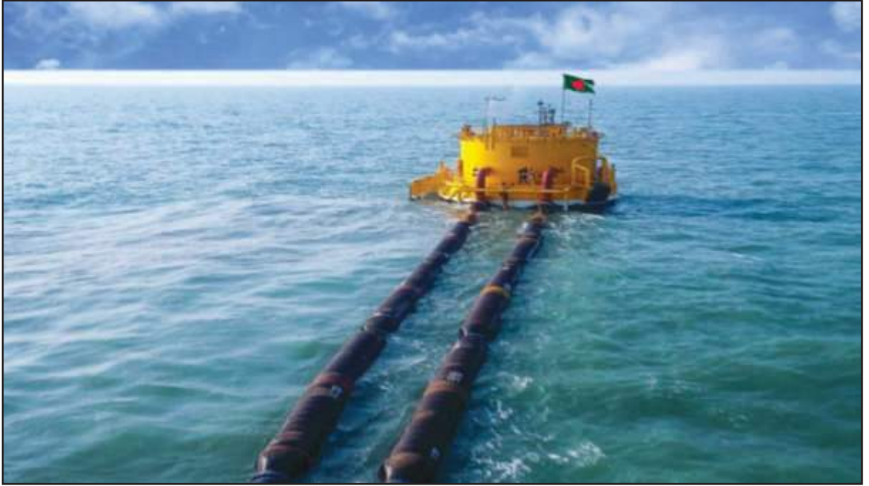
“ইনস্টলেশন অব সিংগেল পয়েন্ট মুরিং (এসপিএম) উইথ ডাবল পাইপলাইন” শীর্ষক প্রকল্পের বঙ্গোপসাগরের নির্ধারিত স্থানে স্থাপিত সিঙ্গেল পয়েন্ট মুরিং বয়ার চিত্র
