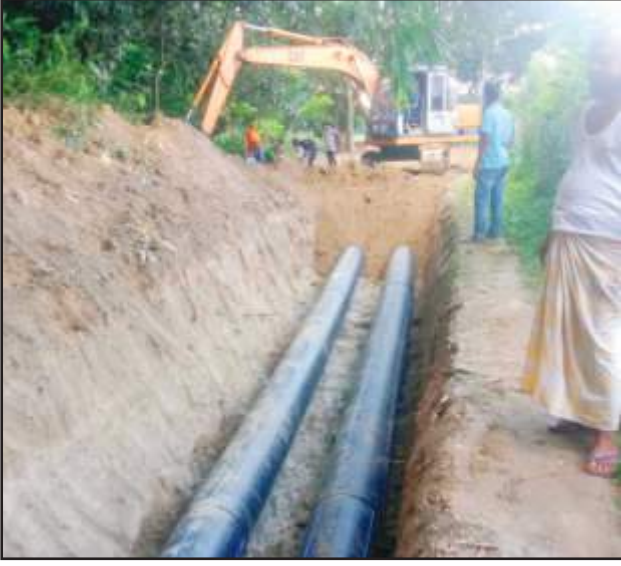
রানীনগর, শিবগঞ্জ উপজেলা, চাঁপাইনবাবগঞ্জ জেলা Buried পাইপ লাইন স্থাপন কাজ চলমান
