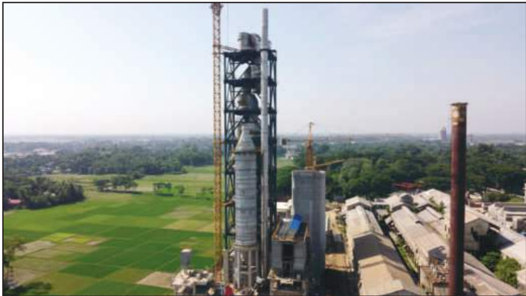
ছাতক সিমেন্ট কোম্পানী লিঃ (Pre-Heater এর মেকানিক্যাল ইনস্টলেশন কাজ চলমান)
